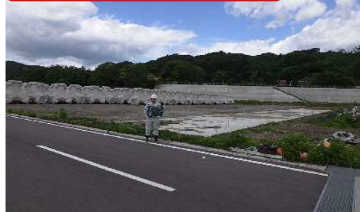
被覆・消波(2)(3)製作ヤード
